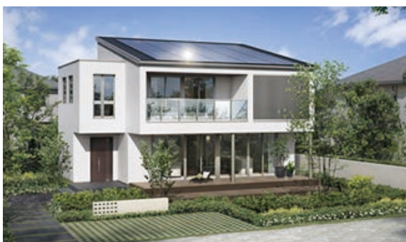
スマートハウス外観
